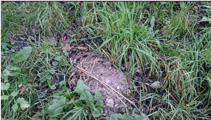
Foto B1.5 Op enkele plaatsen is de afdeklaag vergraven door een mol
